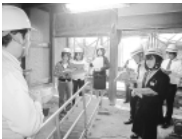
建設中の西岡家住宅
