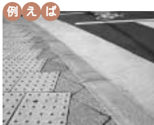
【例えば】 つまずきやすい歩道の段差をスロープ化。視覚障害者の安全のため、点字ブロックも併用。
