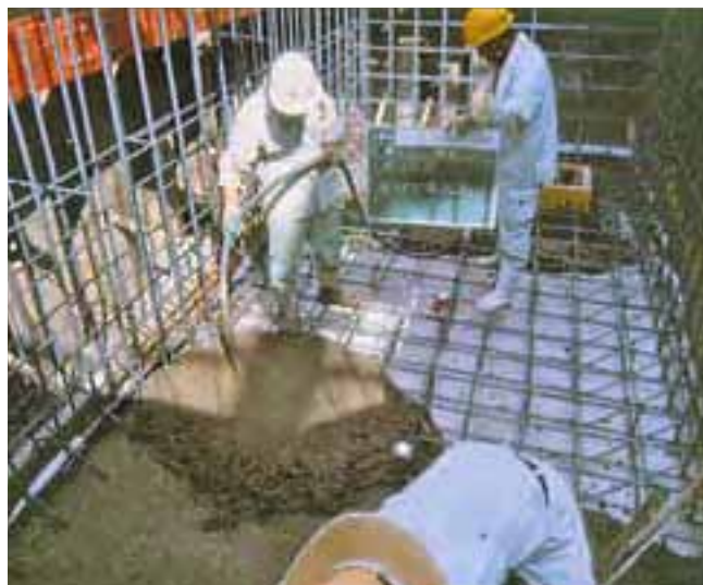
▲ようやく実現した伝建地区の防火水槽
