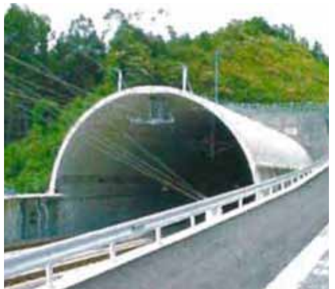
▲ 新幹線トンネル出入口の防音装置
