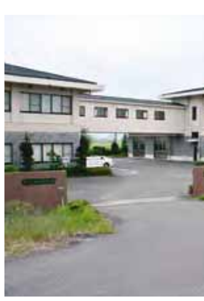
▲ 鹿島藤津のし尿処理場
