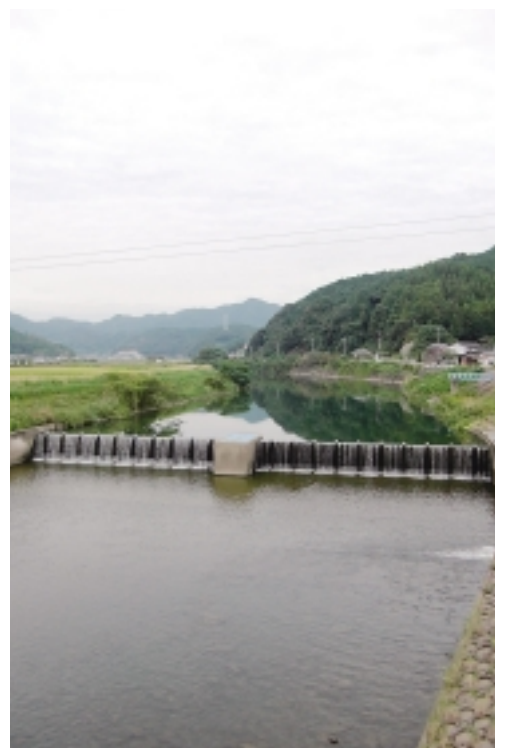
今後、整備される予定の水門
