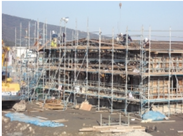
建設中の処理場（三ヶ崎地区）
