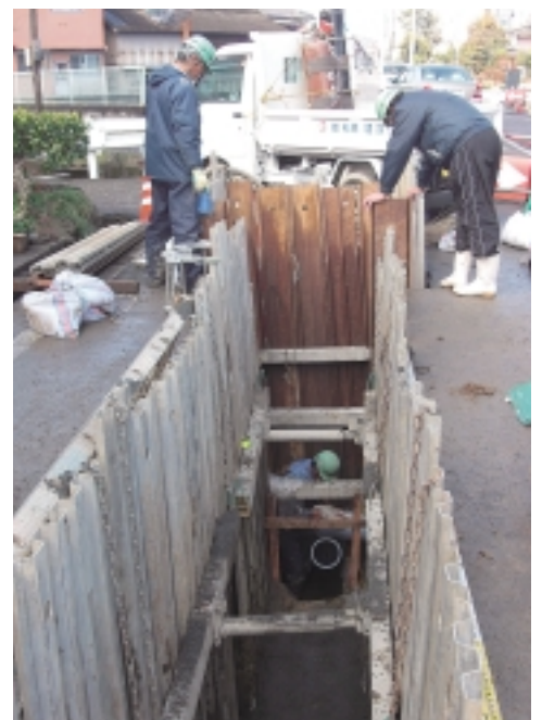
排水管理設が進む五町田地区
