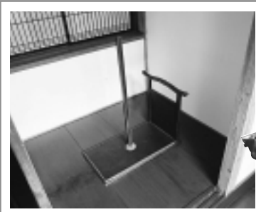
【便所】漆塗りの渡り廊下を抜けると風呂と便所があります。小便器には陶器が用いられ、大便器には竹の表情を現した取手と蓋が付き、意匠が凝らされています。
