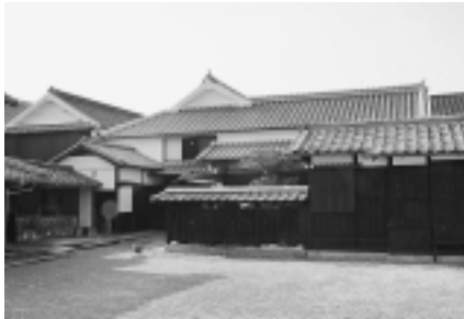
【塩田川から見た完成した西岡家】
