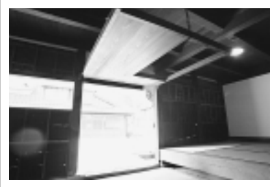
【出入口と見世の間】正面出入口には、潜り戸のついた一間幅の「吊大戸(つりおおど)」と「摺上げ戸(すりあげど)」が建てられ、畳敷きに復原された「見世(みせ)の間」で往時の接客の様子が窺えます。
