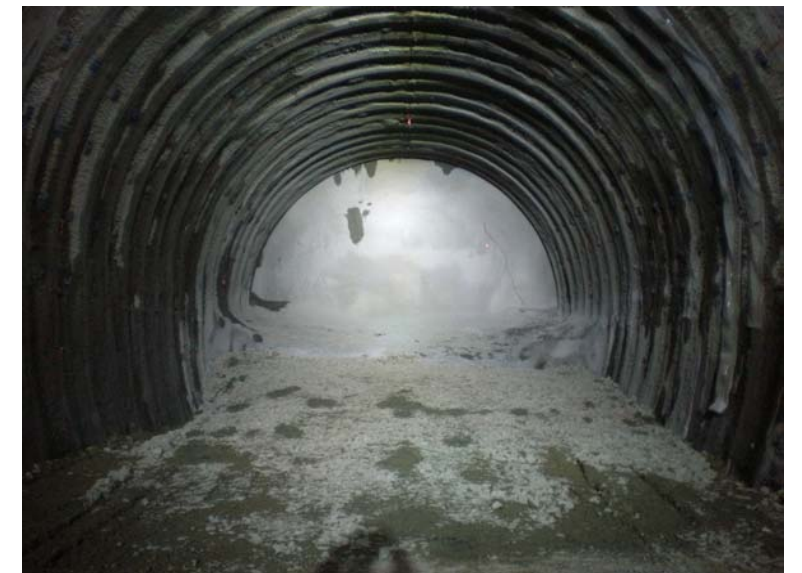
切羽鏡吹付け状況(14km950.8m)
