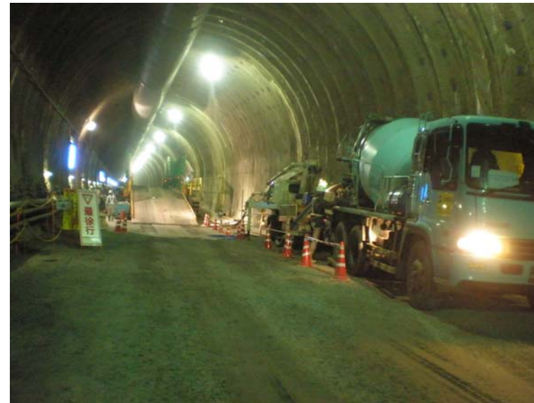
インパートコンクリート打設状況(12BL)
