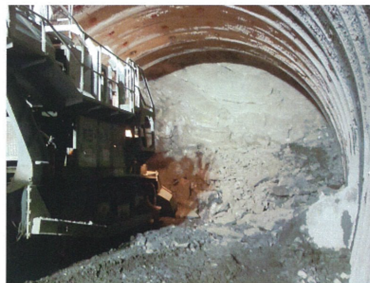
10Jによる切削状況
