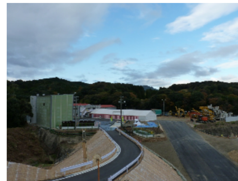
仮設工事作業完了全景
