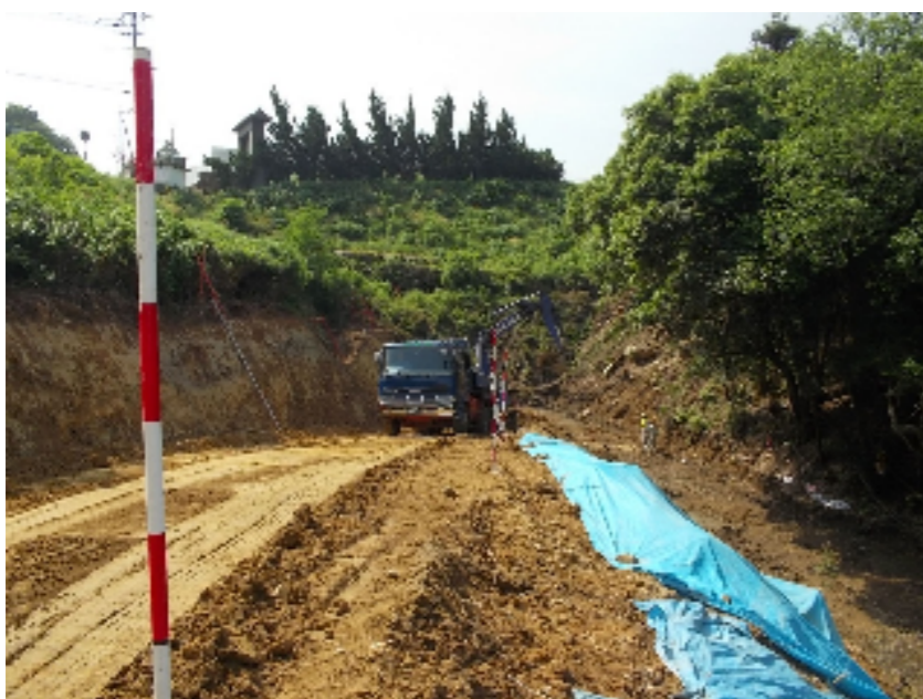
改良盛土②地山掘削作業状況
