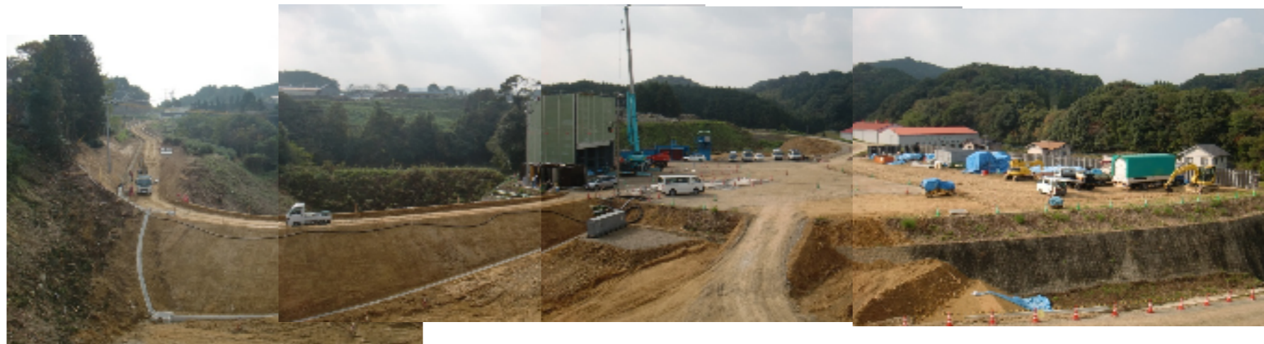
仮設工事作業状況
