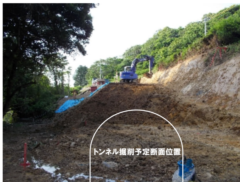
改良盛土②地山掘削作業状況
