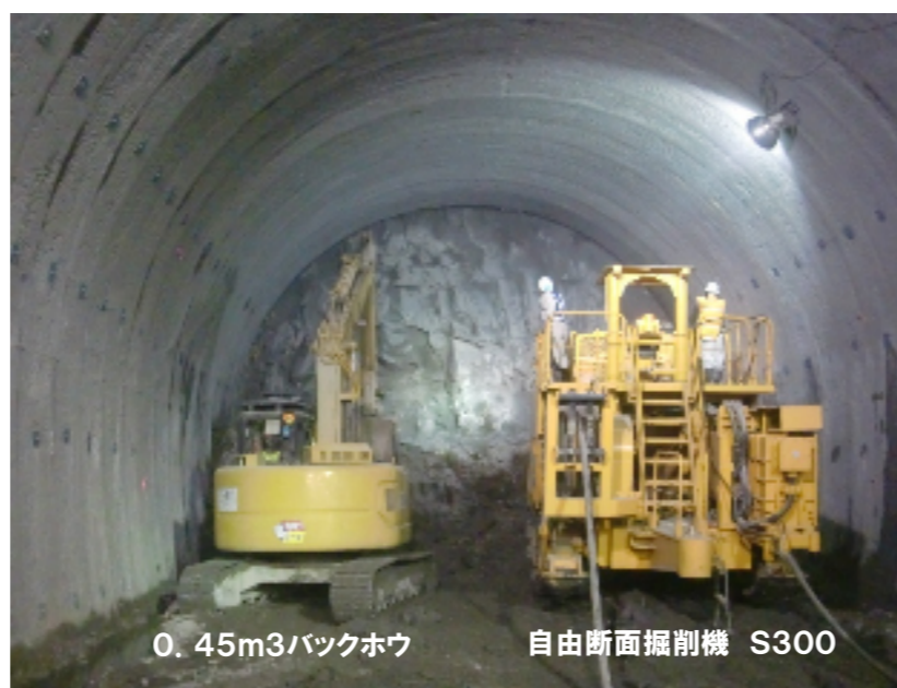
トンネル掘削作業状況
