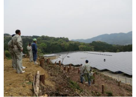
(3) 祇園土捨場（吉田地区） （メガソーラー建設中）
