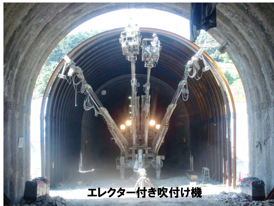
トンネル鋼製支保工建込み作業状況
