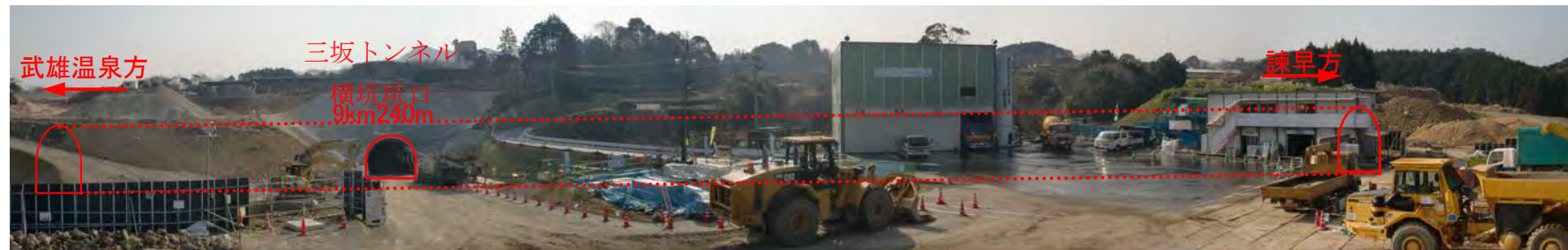
仮設工事作業状況
