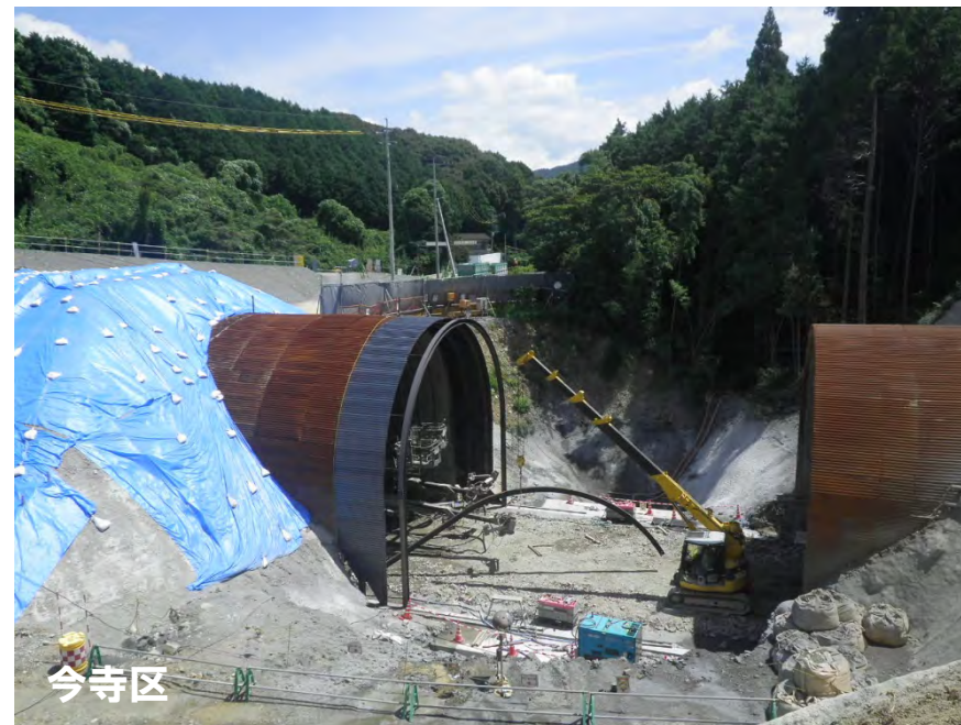
トンネル鋼製支保工建込み作業状況
