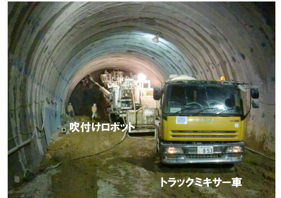
トンネル一次支保（一次吹付け）設置作業状況
