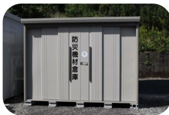
防災機材倉庫
