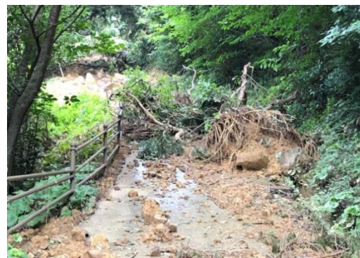
虚空蔵山参道の被害状況
