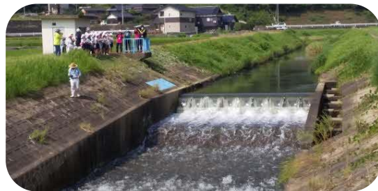
可動堰の作動確認
