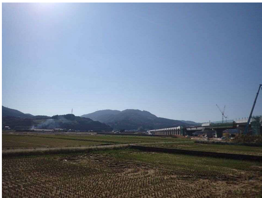
建設が進む九州新幹線西九州ルート
