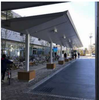
〔車寄せの事例(平塚市庁舎)〕
