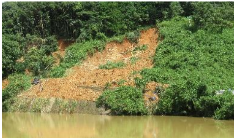
県道大木場武雄線(土砂崩れ)ため池 に土砂流入 (昨年)
