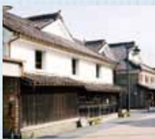
豪商・廻船問屋の屋敷「西岡家住宅」
