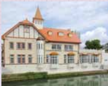
市営公衆浴場「シーボルトの湯」はかつての藩営浴場。江戸参府をしたケンペルやシーボルトも利用した
