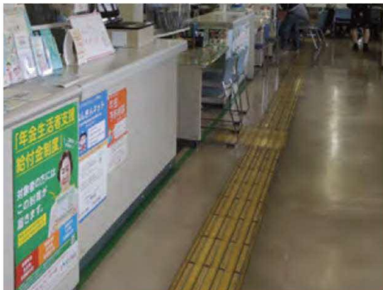
点字ブロック付近に什器が配置されているため、目の不自由な方の通行の妨げになっている
