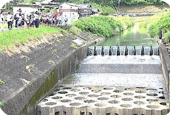
↑堰の開閉も見学
