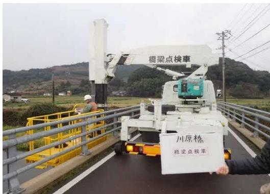
橋梁点検車による定期点検
