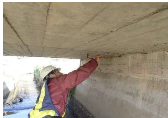
定期点検(打音検査)状況
