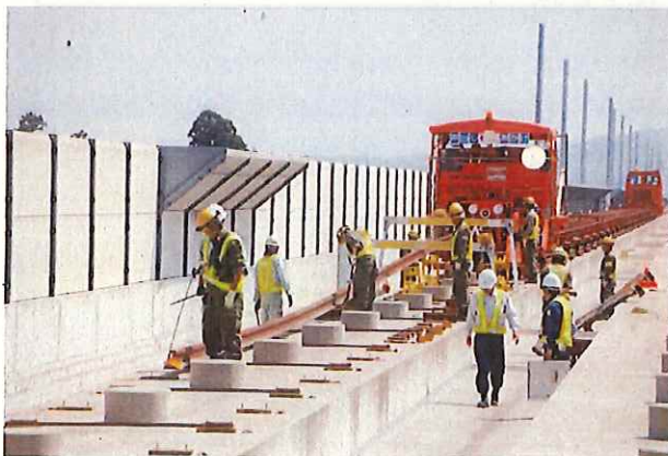
レール敷設作業(北陸新幹線の例)
