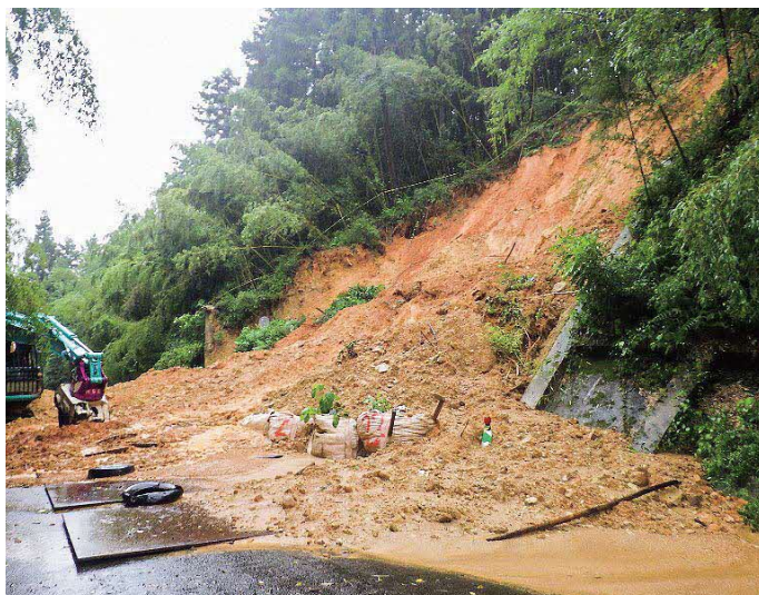
市道・堤の上線で発生した土砂崩れ
