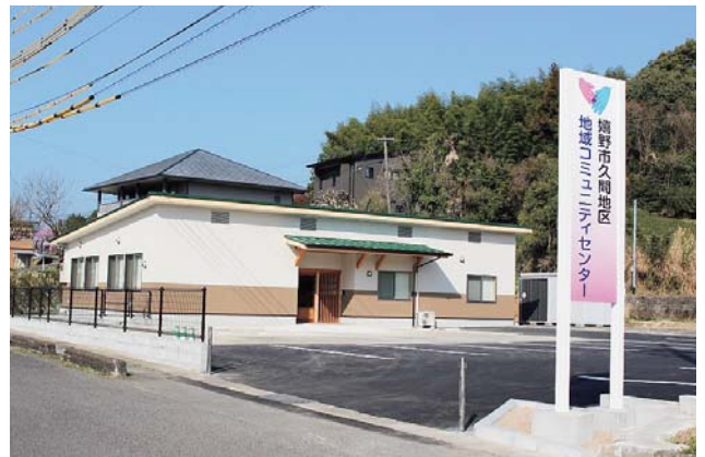
久間地区地域コミュニティセンター全景
