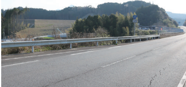
▲松浦バイパス沿いに整備された工業団地
