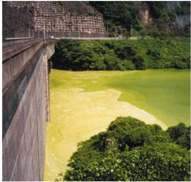
▲平成17年の「アオコ」発生状況（岩屋川内ダム）
