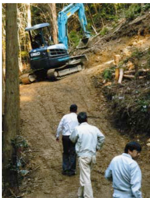
▲安くて丈夫な作業林道(高知県四万十町)
