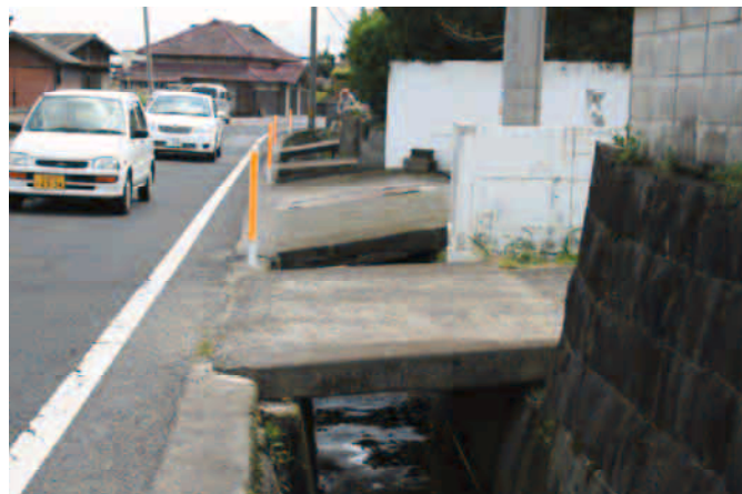
▲公有水面上に架けられた個人用の橋
