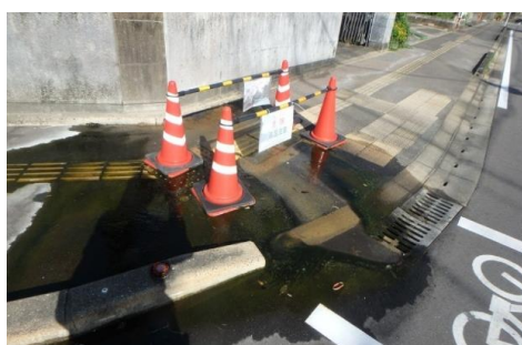
配管埋設部からの漏湯発生状況
