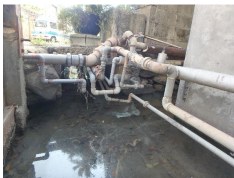
配湯管敷設状況-1（水路内）
