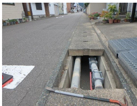
配湯管敷設状況-2（側溝内）
