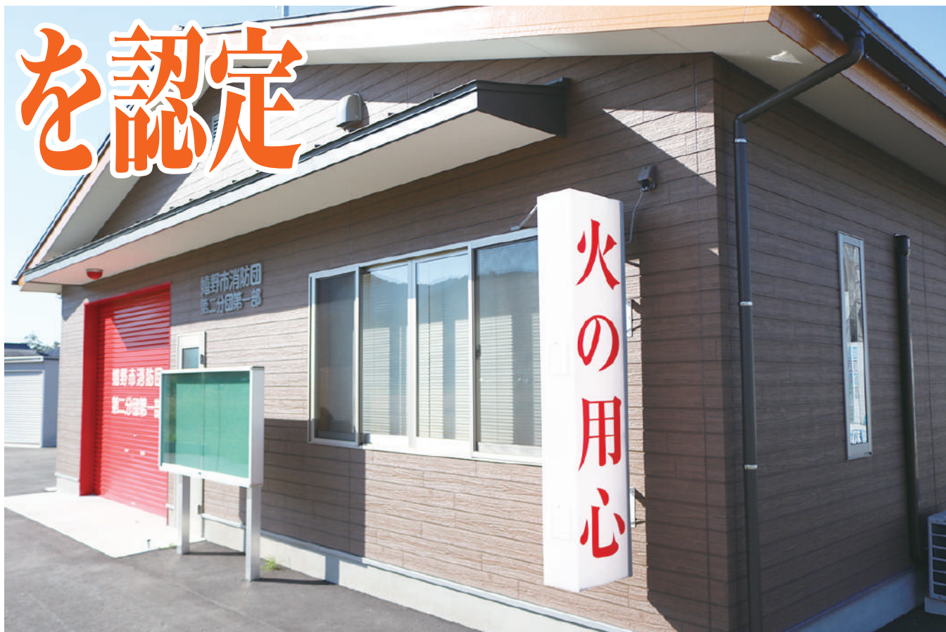
▲令和2年度に新築された消防機庫（五町田地区）
