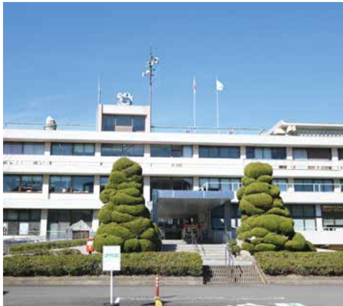
▲強度不足の嬉野庁舎
